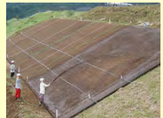
吹き付け植栽状況
