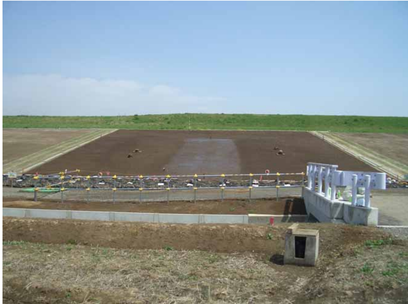
「ピオ・セル・ショット工法によるチガヤ苗吹付工」施工完了(2010.4.21撮影)
