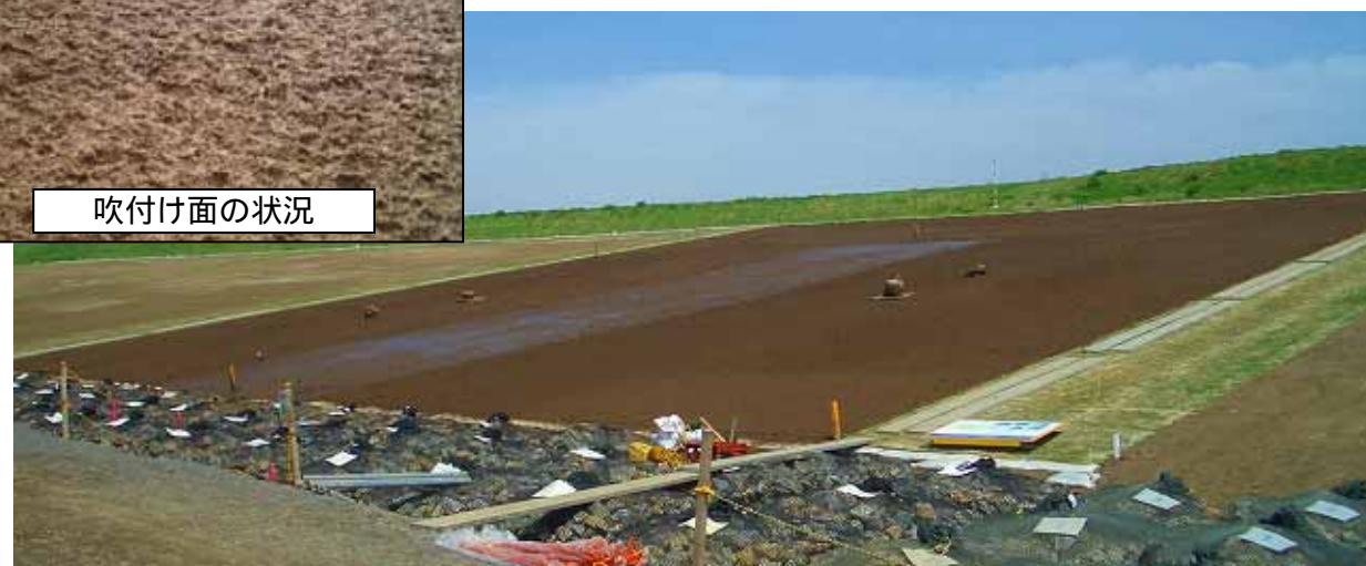
吹付け完了直後
