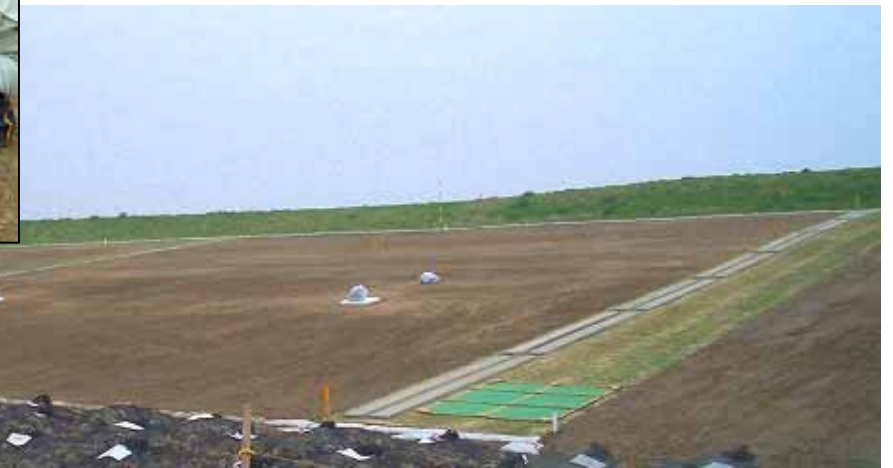
吹付工 着手前
