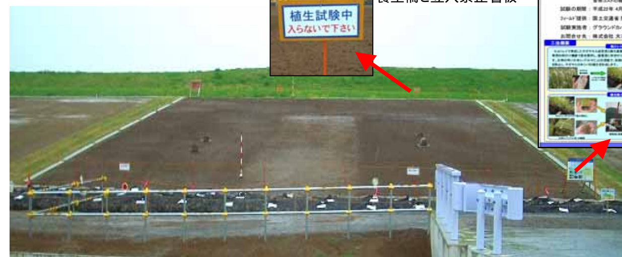
看板類等の設置
