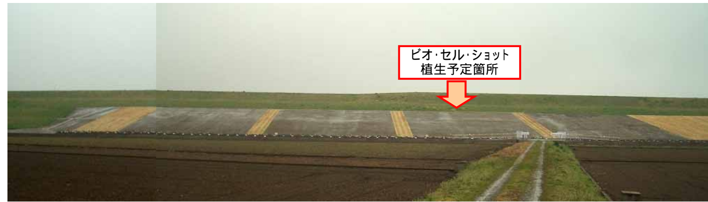
利根川フィールド全景(2010.4.5撮影) 全ブロック未着手
