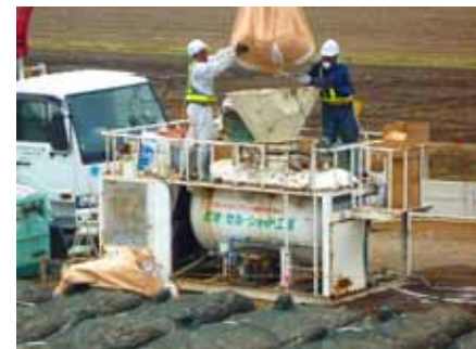
植物苗と基盤材等の混合攪拌作業
