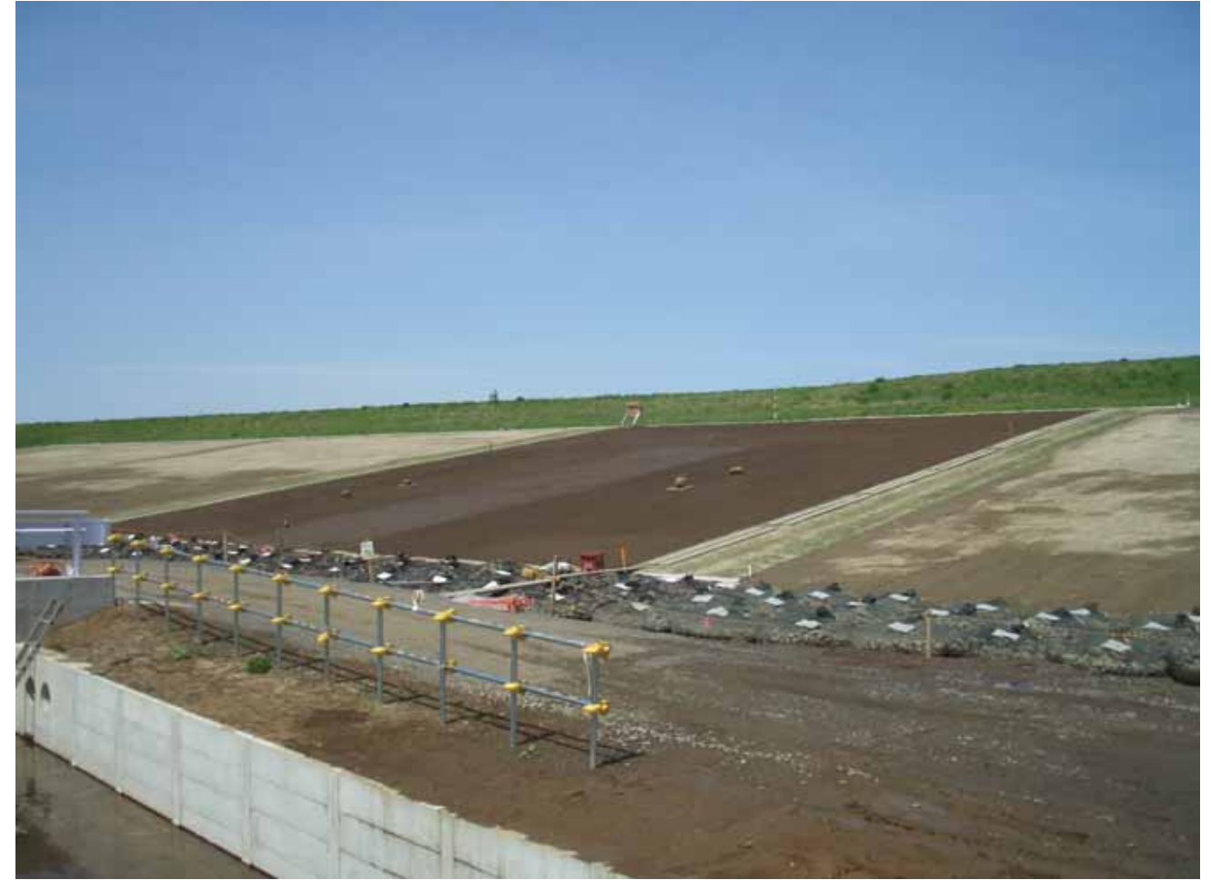
「ピオ・セル・ショット工法によるチガヤ苗吹付工」施工完了(2010.4.21撮影)
